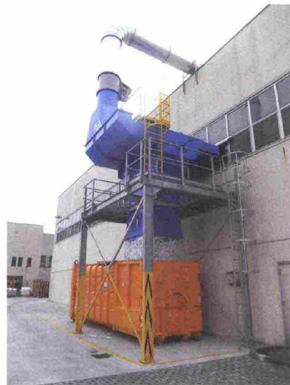
Sistema di scarico con struttura autoportante
