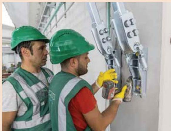
Montaggio del sistema Jawfix
