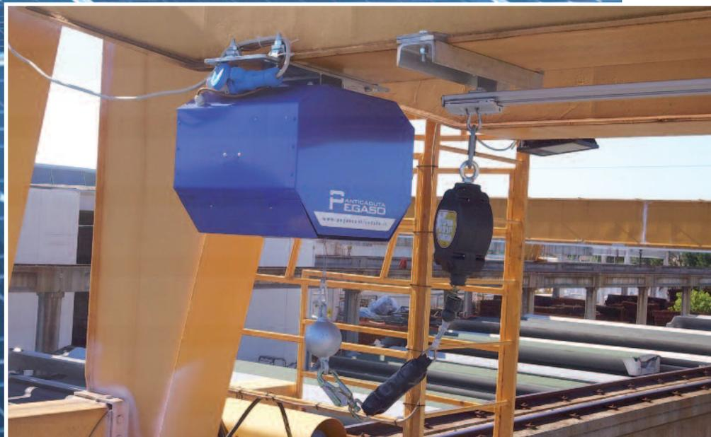
**IL SISTEMA ANTICADUTA DI MANINI** Per consentire la lavorazione in quota in sicurezza degli operatori al reparto stoccaggio, si adotta il sistema costituito da: linea vita rigida classe D, dispositivo anticaduta retrattile (immagine pagina seguente) e imbracatura anticaduta.
