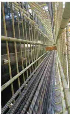
Armature in fibra di vetro (GFRP Glass Fiber Reinforced Polymer) per il nuovo ponte di Gonnese.
