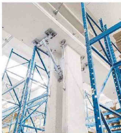
Jawfix L'idea è nata in seguito agli eventi sismici e la caratteristica del dispositivo è quella di dissipare la forza attraverso l'attrito
